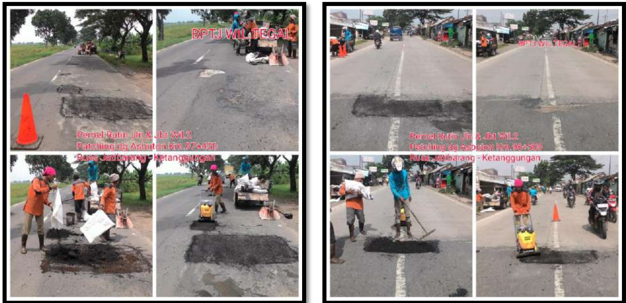
Gambar 5.5 Penanganan Kerusakan Jalan
