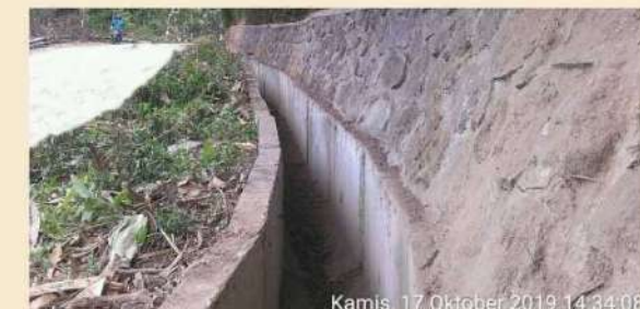
PEKERJAAN NORMALISASI SALURAN RUAS JALAN : BLABAK - JRAKAH NO 183 KM MGL. 24+600 KN
