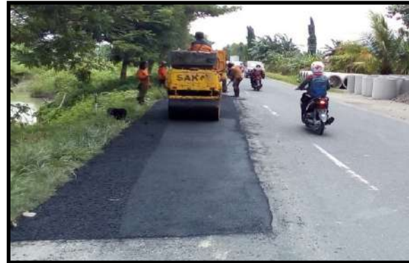
Pekerjaan Patching dengan CAP Salatiga - Kedungjati ( 189 ) Km. Smg. 54 + 990
